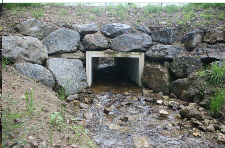
Après travaux : nouveau franchissement sur un nouveau tracé du lit dans le talweg
